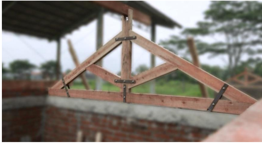
Gambar 28. Kuda-kuda Kayu Dengan Pengikat Plat Baja
