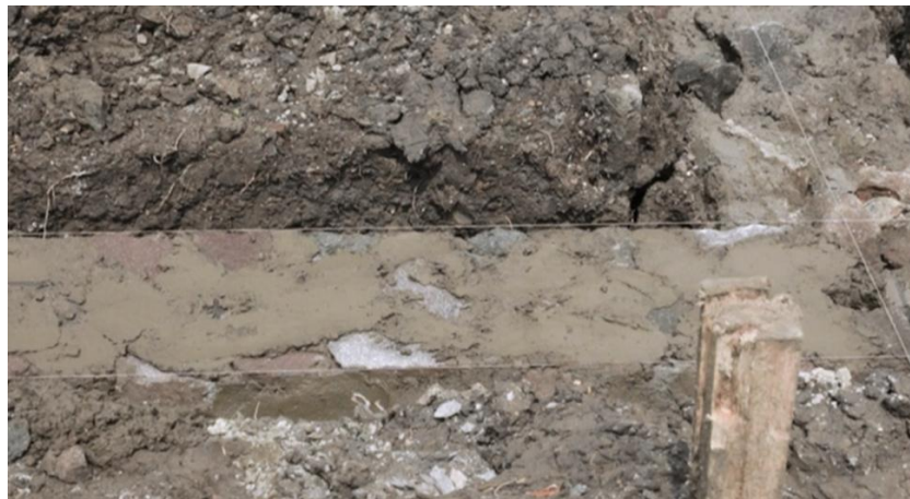
Gambar 11. Pondasi Dari Batu Kali/Gunung
