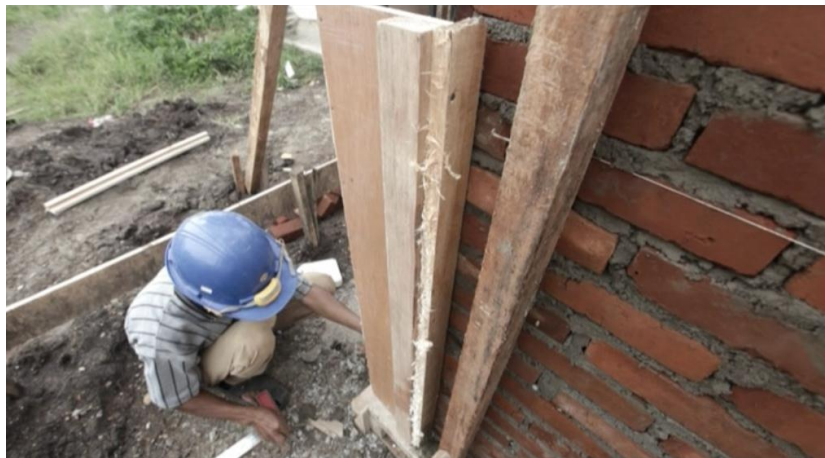
Gambar 55. Pemasangan Cetakan/ Bekisting Untuk Kolom
