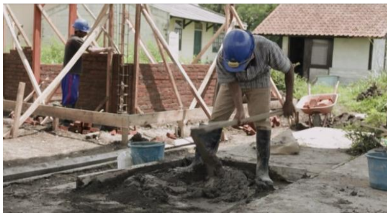
Gambar 8. Proses Pencampuran Mortar
