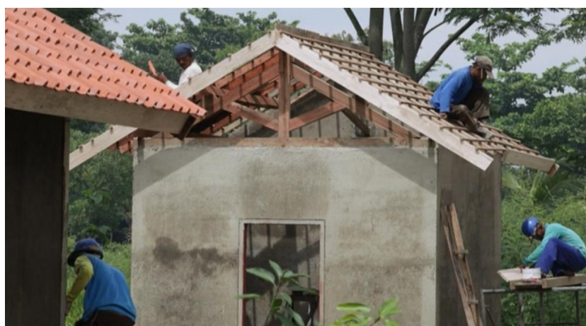
Gambar 27. Kuda-kuda Kayu Pada Atap Rumah Tinggal
