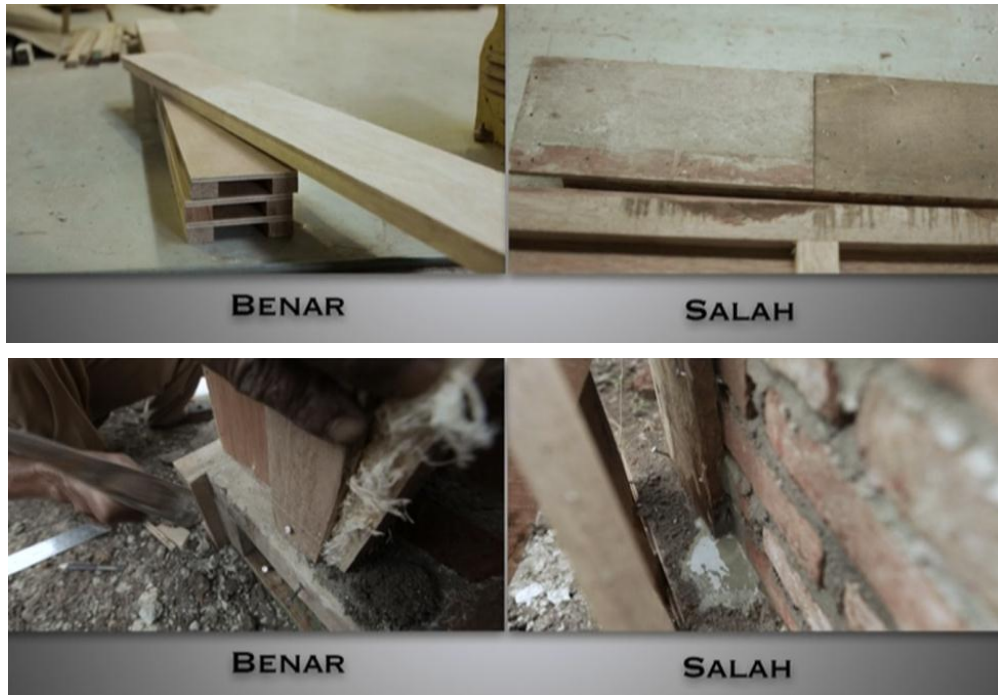
Gambar 54. Kualitas Cetakan/ Bekisting
