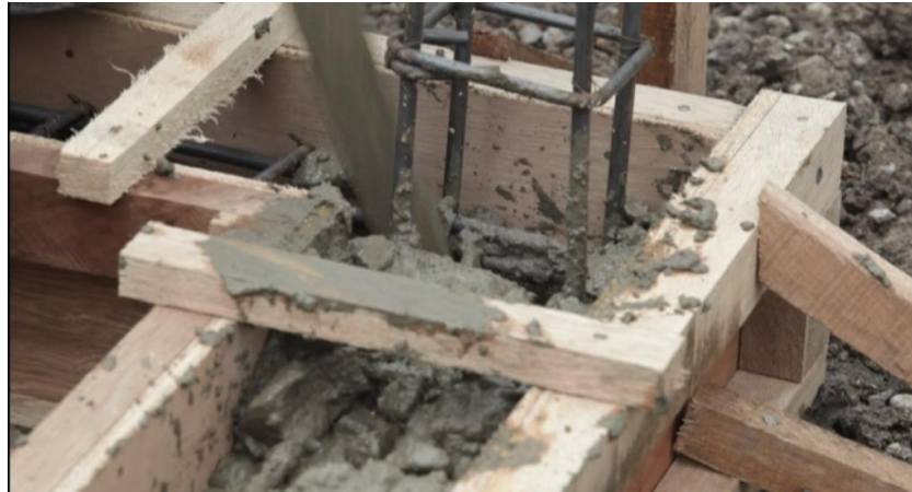
Gambar 58. Pengecoran Balok Pengikat/ Sloof
