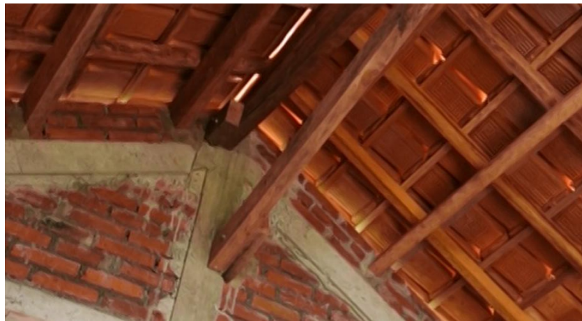
Gambar 37. Pertemuan Antara Ikatan dengan Gunung-Gunung/ Ampig
