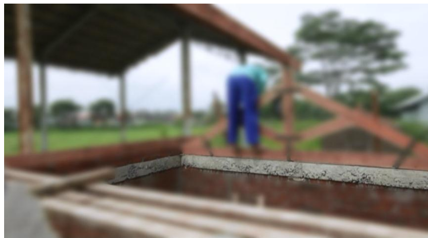
Gambar 22. Balok Keliling/ Ring
