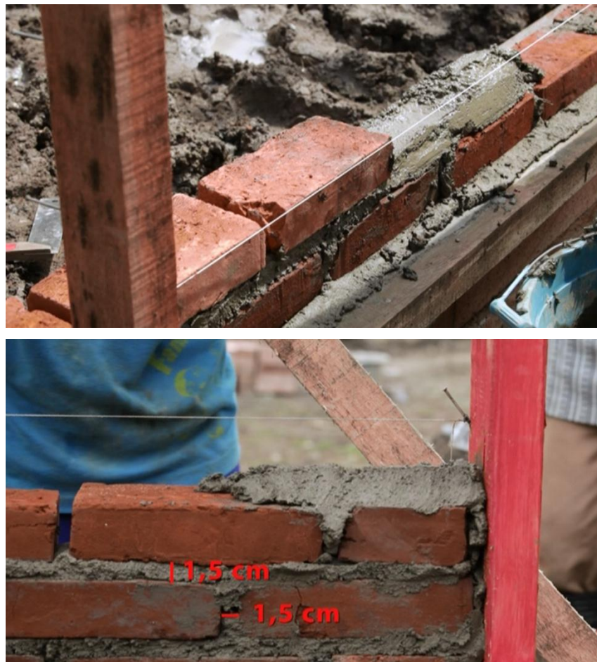
Gambar 41. Proses Pemasangan Batu Bata Untuk Dinding
