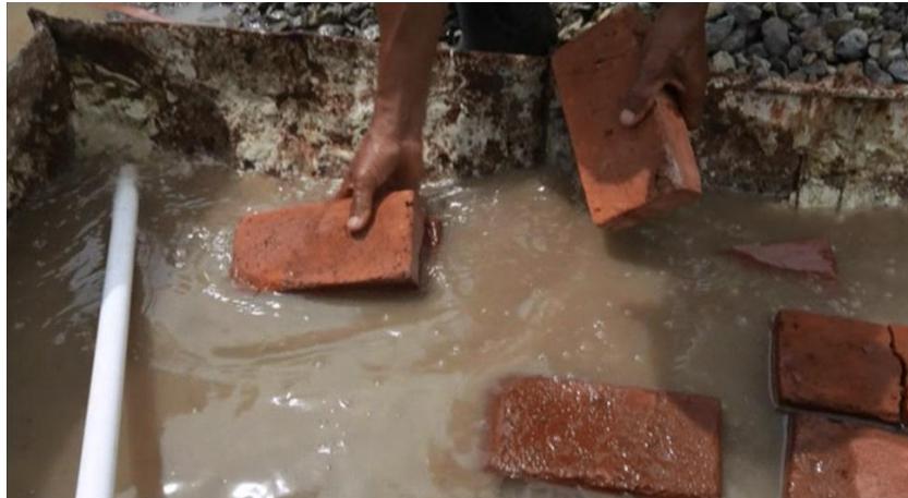
Gambar 15. Perendaman Batu Bata Sebelum Dipasang
