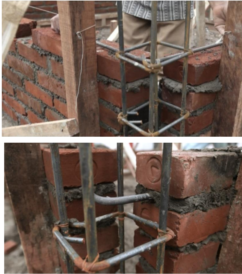
Gambar 47. Pemasangan Angkur Besi Sebagai Pengikat Antara Kolom dengan Dinding Pada Sudut Bangunan
