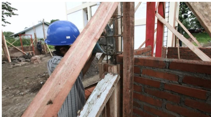
Gambar 56. Proses Pengecoran Kolom
