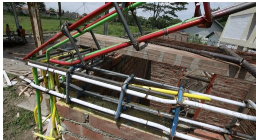
Gambar 53. Hubungan Antara Tulangan Bingkai Gunung-Gunung/ Ampig dengan Tulangan Kolom dan Balok Keliling/ Ring
