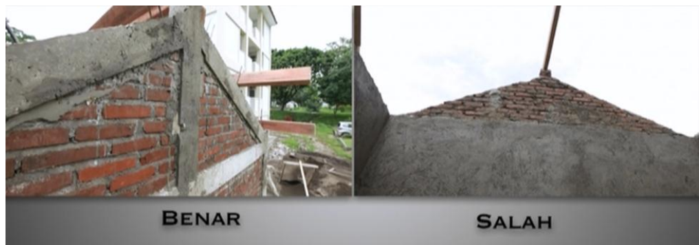
Gambar 32. Gunung-Gunung/ Ampig
