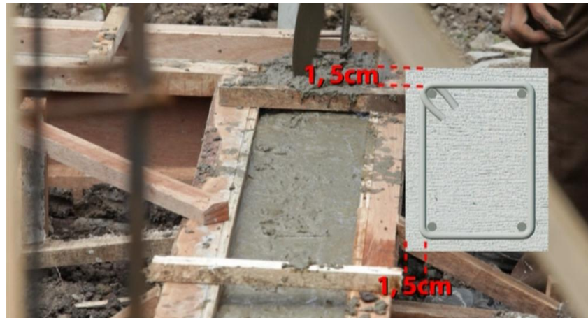
Gambar 19. Balok Pengikat/ Sloof
